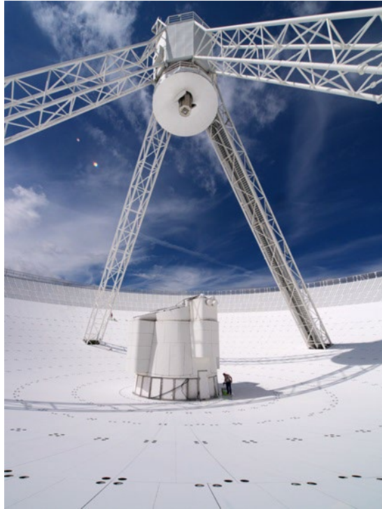
Abb. 10: Spiegeloberfläche des Radioteleskops Effelsberg, zusammengesetzt aus 2360 Einzelteilen (den sogenannten Paneelen) mit insgesamt über 9000 Quadratmeter Fläche. Von der Schüssel aus führen vier Stützbeine ca. 30 m hoch bis zur Fokuskabine, die sich in waagerechter Position fast 100 m über dem Boden befindet. Dort kommt eine Reihe von Empfängern zum Einsatz. Es ist aber auch möglich, die Radiostrahlung durch einen zweiten Spiegel (Subreflektor von 6,50 m Durchmesser) nochmals umzulenken in die zweite Empfängerkabine im Zentrum des großen Spiegels. (Foto: Norbert Tacke/MPIfR).
