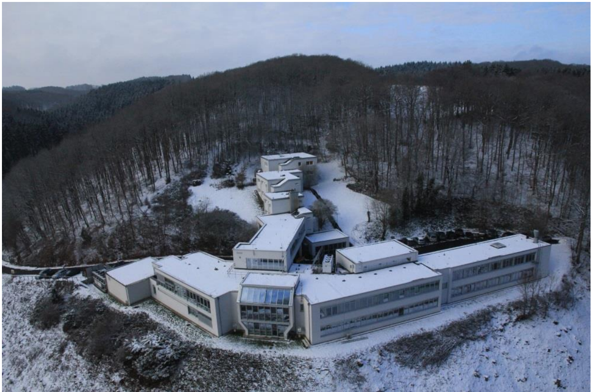
Abb. 8: Hauptgebäude des Radio-Observatoriums Effelsberg, fotografiert aus 50 m Höhe. Hinter der großen Frontscheibe befindet sich der Steuerraum für das 100-m-Radioteleskop (Foto: N. Junkes, MPIfR).
