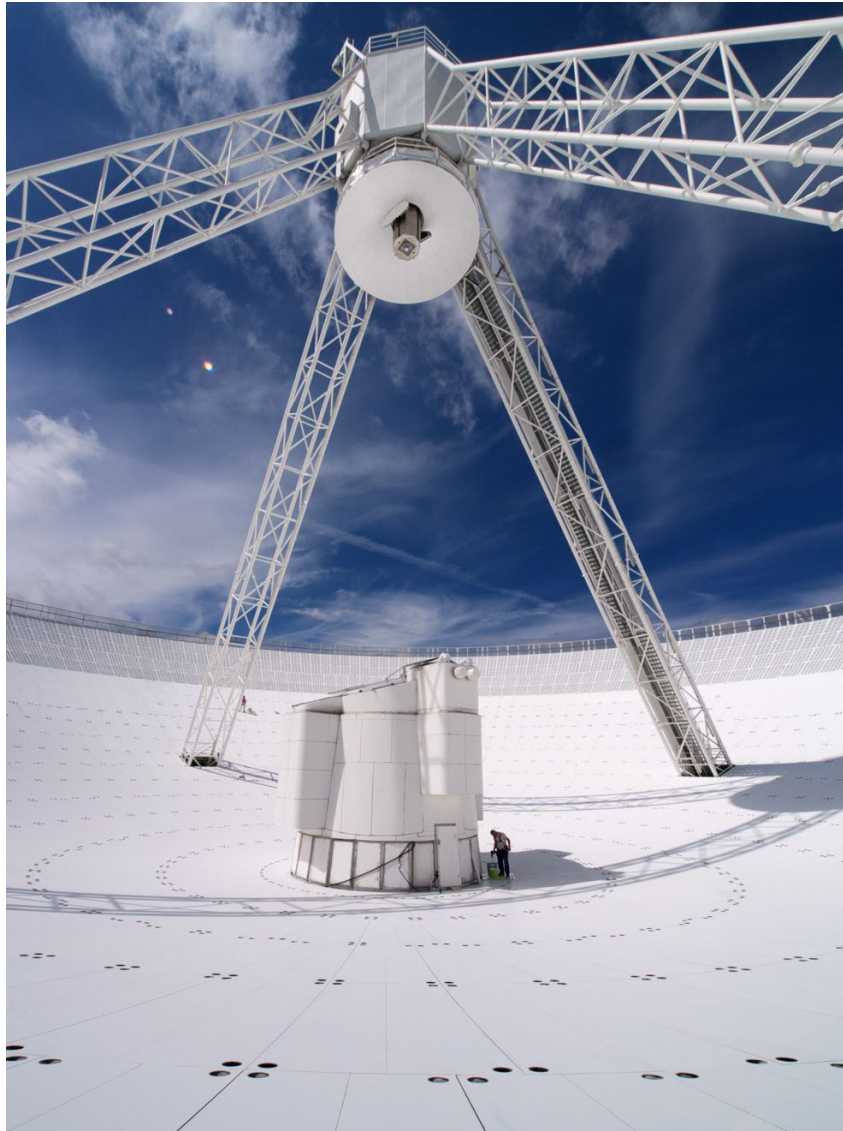
Abb. 6: Primär- (PFK) und Sekundärfokuskabine (SFK) des 100-m-Radioteleskops Effelsberg. Die PFK markiert den Brennpunkt in 30 m Höhe über dem Parabolspiegel. Der dort positionierte Empfänger kann elektrisch zurückgefahren werden; dann wird der Strahlenweg über den Sekundärspiegel von 6,50 m Durchmesser in die SFK im Zentrum des Hauptspiegels umgelenkt. Foto: Norbert Tacken/MPIfR.
