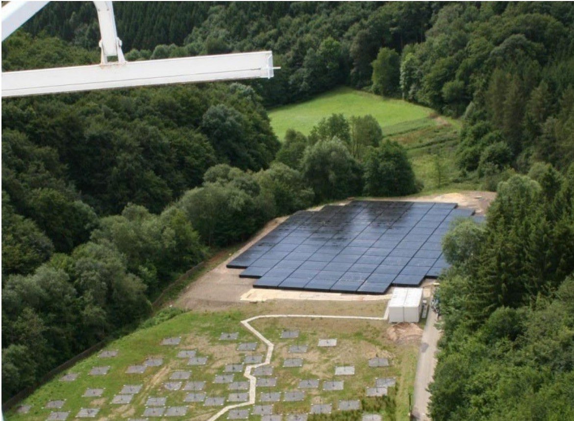
Abb. 8: LOFAR-Station Effelsberg, aufgenommen aus 50 m Höhe vom Turmlabor des 100-m-Teleskops. Vorne: LOFAR-LOW für 25 bis 85 MHz (4-10 m Wellenlänge); hinten: LOFAR-HIGH für 120-240 MHz (1-3 m Wellenlänge). Foto: James Anderson.
