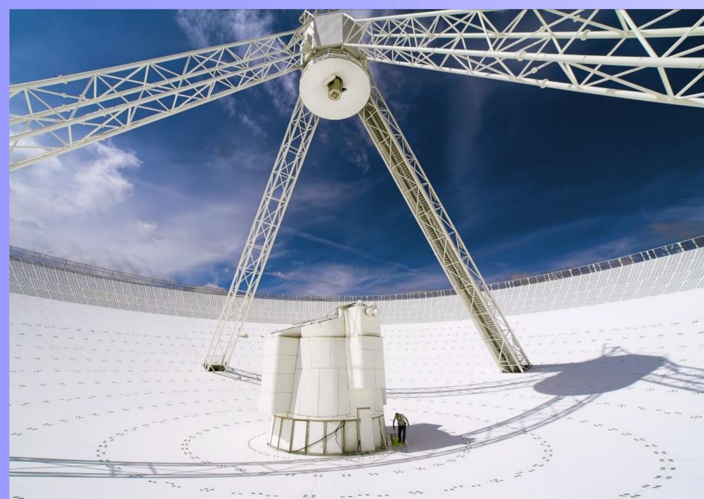
Abb. 2: Primär- und Sekundärfokuskabinen des Radioteleskops Effelsberg mit aktivem Empfänger im Primärfokus. Bild: Norbert Tacken/MPIfR
