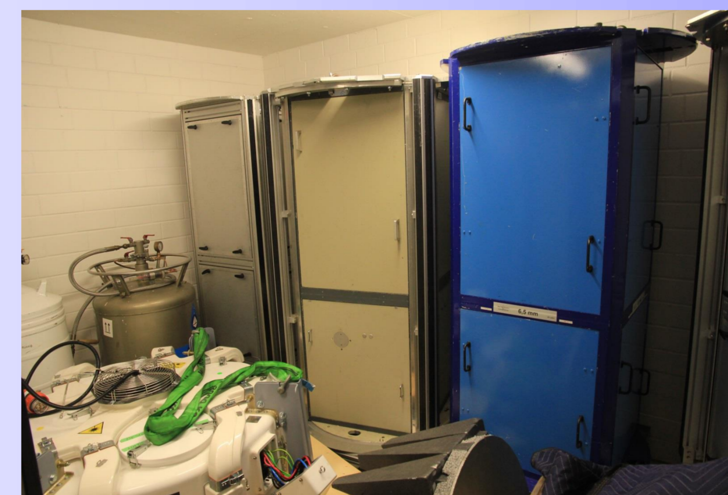
Abb. 3: Empfängerboxen zum Einsatz im Primärfokus des Radioteleskops Effelsberg. Links unten (in Weiß) ist der „Phased Array Feed“ (PAF)-Empfänger zu sehen. Bild: Norbert Junkes/MPIfR
