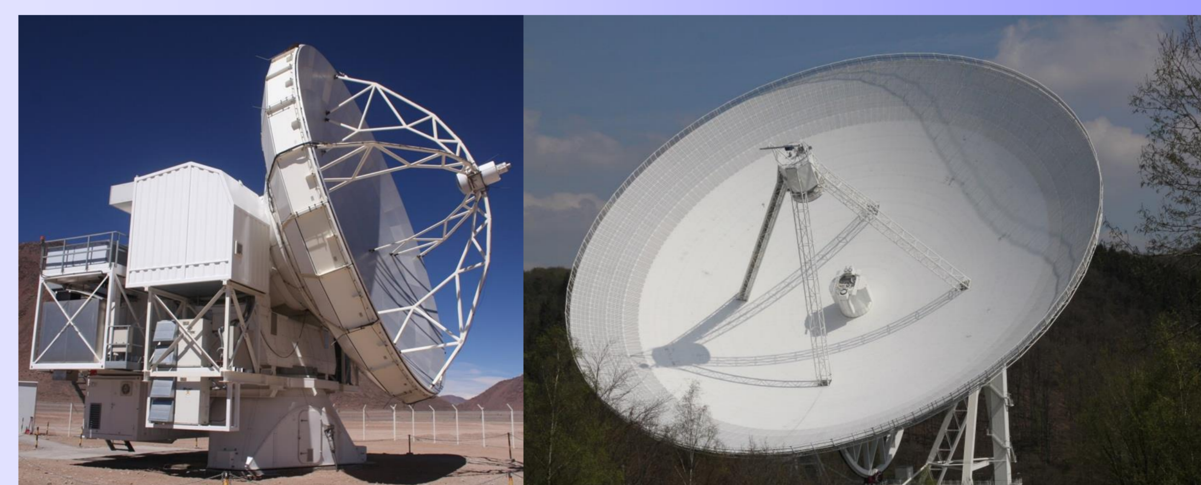
Abb.3: Links: Atacama Pathfinder Experiment (APEX), ein Radioteleskop mit 12 m Durchmesser in 5100 m Höhe in Chile. Rechts: 100-m-Radioteleskop Effelsberg (Bilder: Norbert Junkes/MPIfR)
